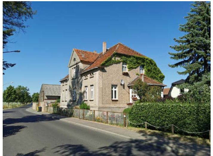
Abb.18: Wohngebäude an der Geiselbergstraße
