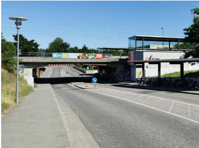
Abb.23: Unterführung am Bahnhof, Foto: ARGUS
